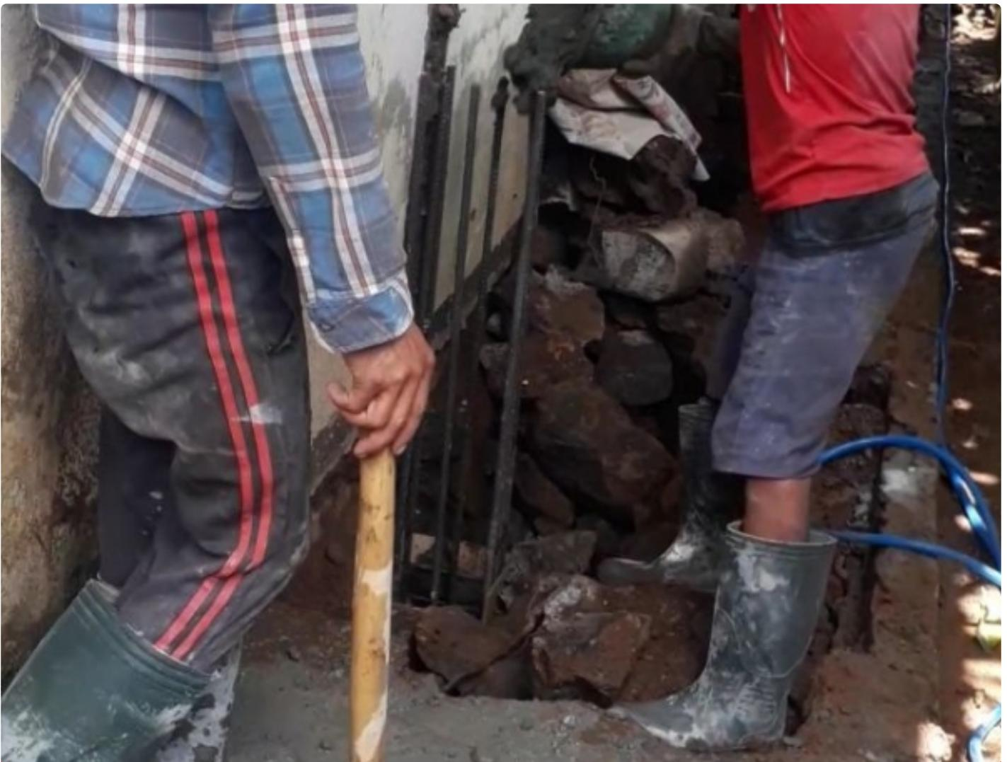
*Pekerja memasukan adukan manual coran beton ke kolom ( foto dok: Indonesiasatu.co.id)*
